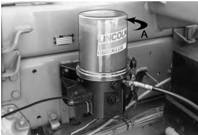
Abb. 9-1 Behälter der Pumpe befüllen
